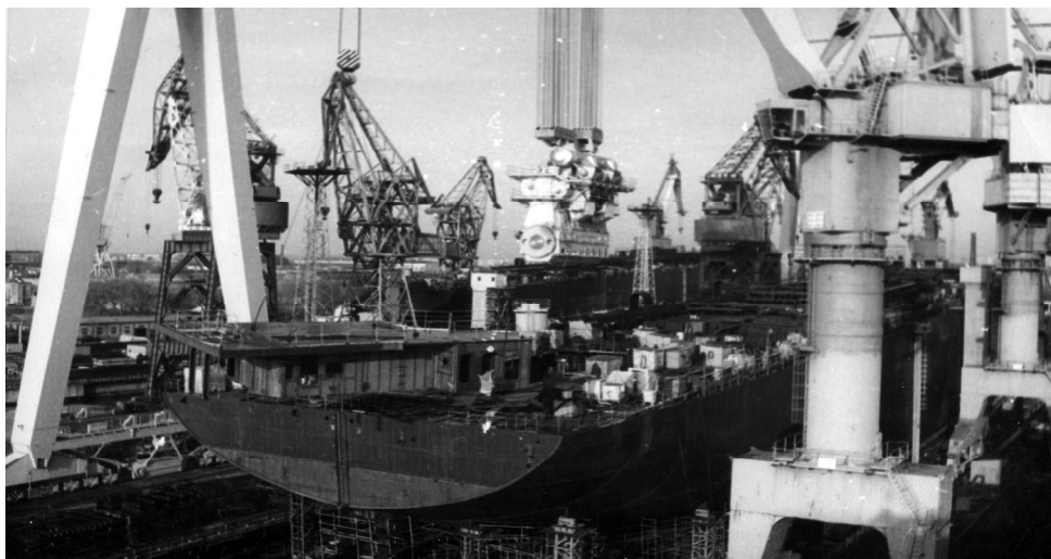
Рис. 4. Погрузка двигателя БДКРН 80/229 на танкер, строящийся на стапеле Черноморского судостроительного завода
